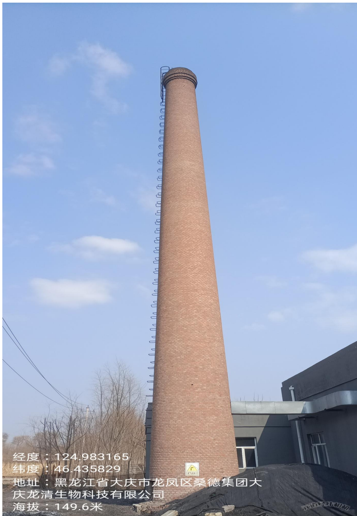
生物质采暖炉 35m 高排气筒
