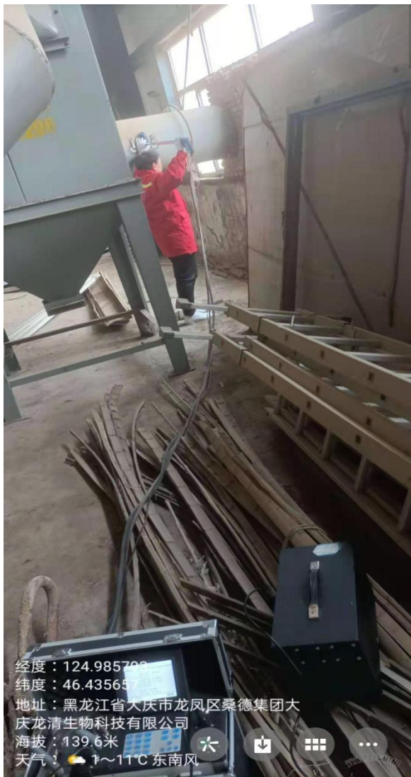
热风炉空排气筒处理后监测口
