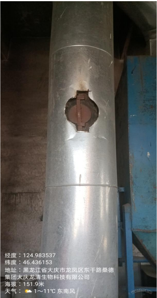
生物质采暖炉烟气处理后监测口
