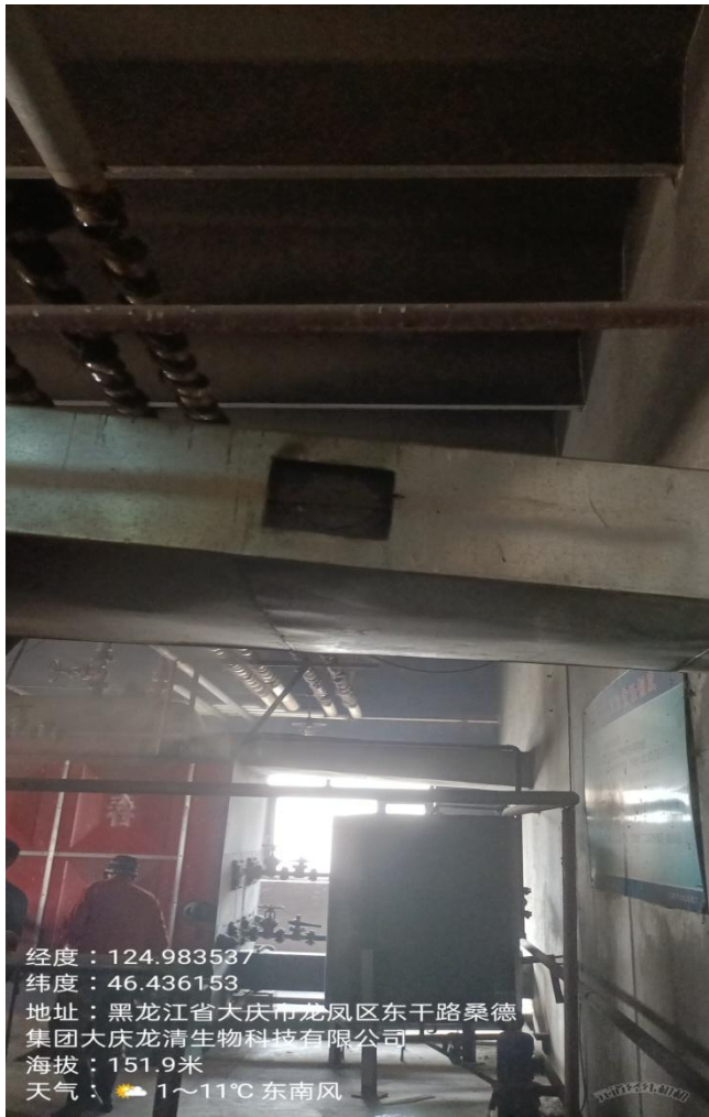
生物质采暖炉烟气处理前监测口
