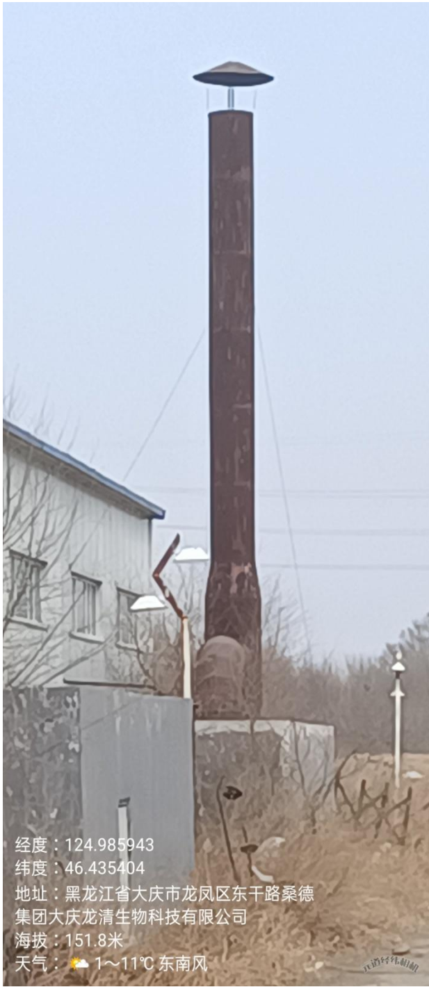
热风炉空排放 15m 高排气筒
