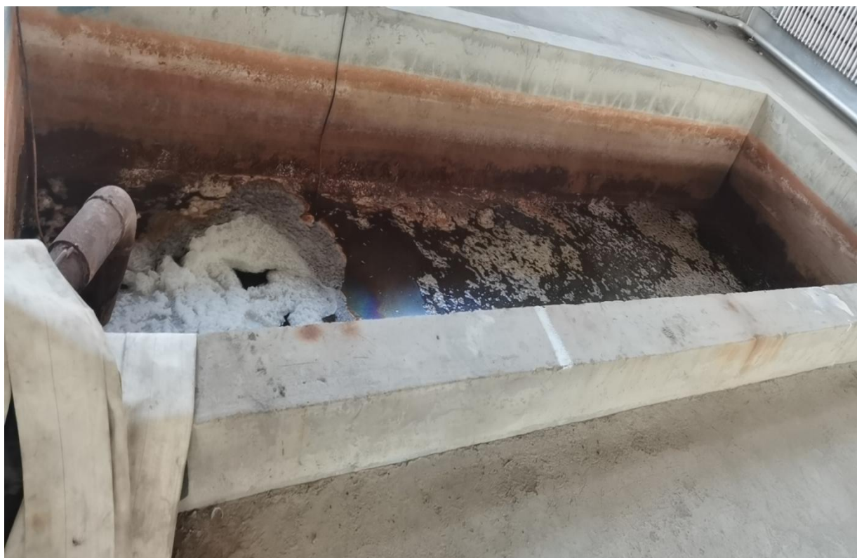
压滤液贮存池
