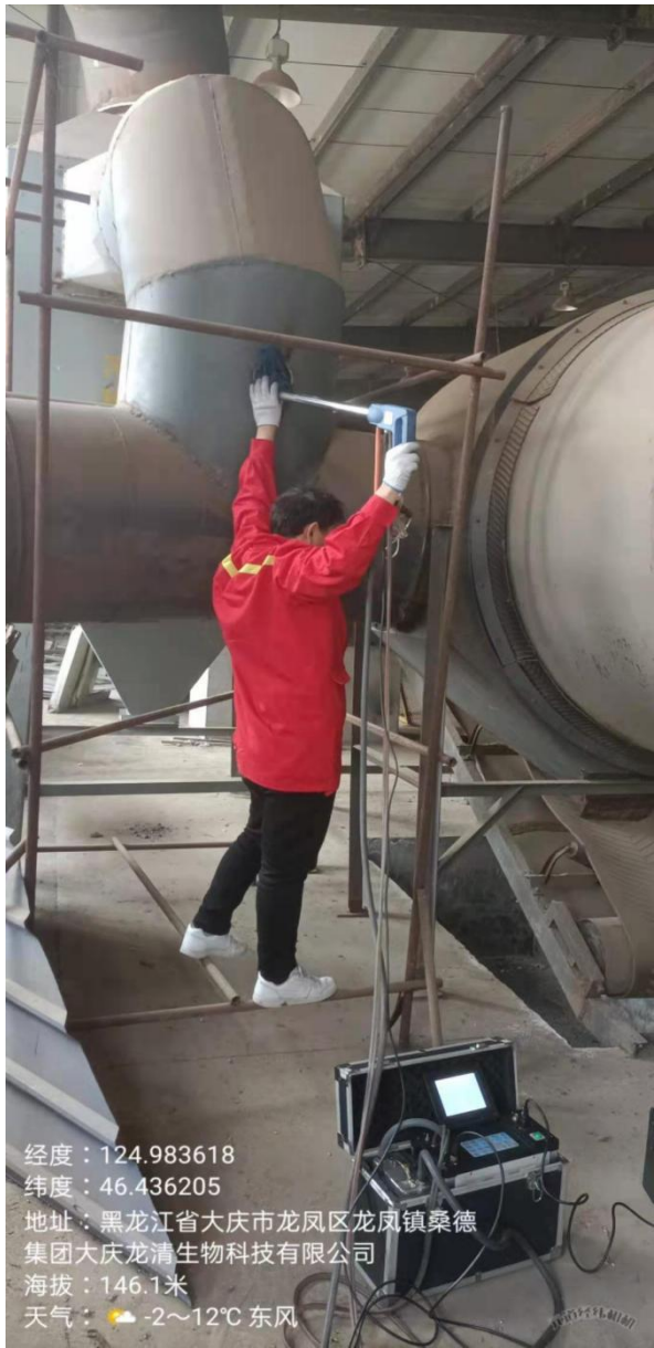
热风炉空排气筒处理前监测口
