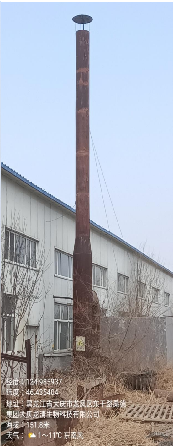
冷却设备 15m 高排气筒
