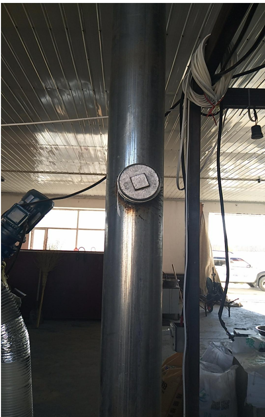
旋风除尘器及除尘前监测孔
