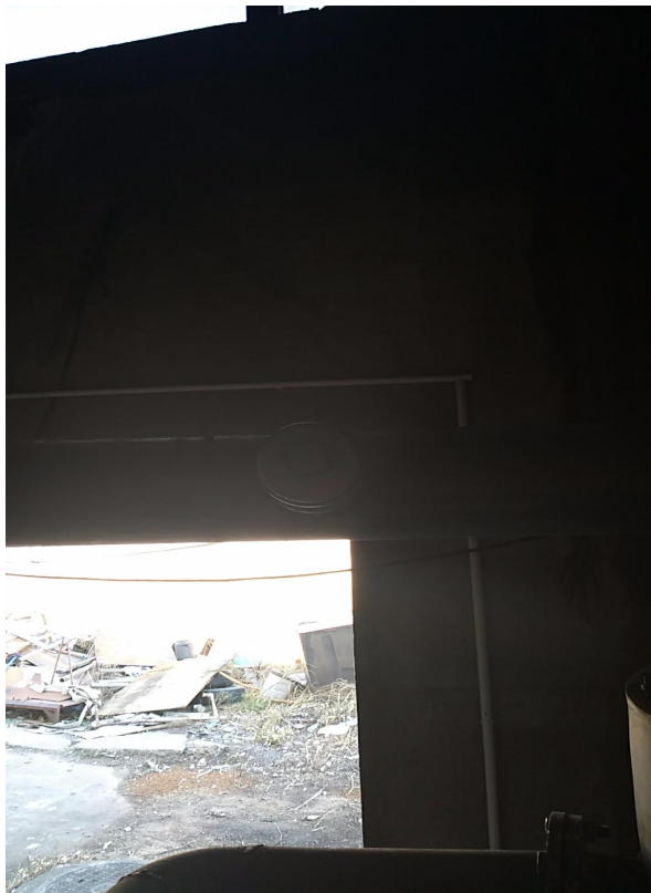
生物质锅炉除尘器前、后检测孔
