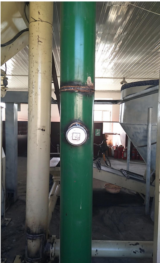
旋风除尘器及除尘前监测孔
