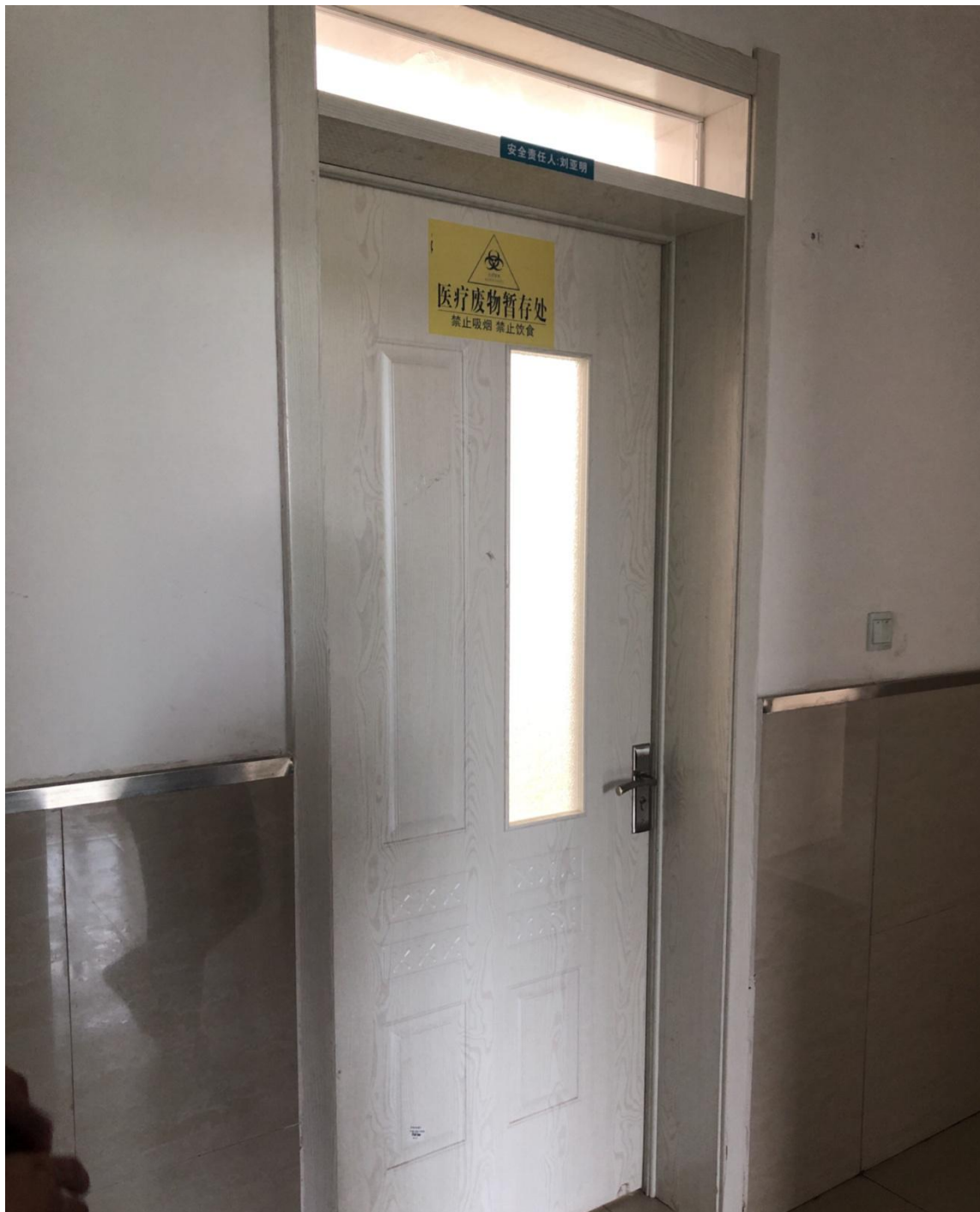
附图：危废暂存间
