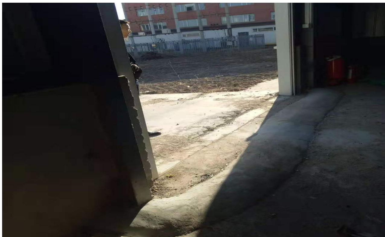
危废暂存间围堰
