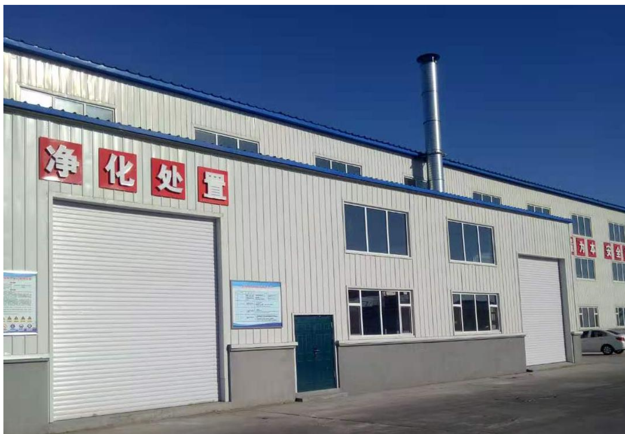
喷漆工艺过滤棉+活性炭吸附装置
